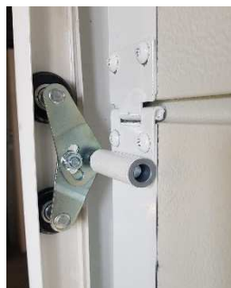
Fig. 17 (Attenzione rispettare la posizione della cerniera silenziata, nella foto si vede il lato sinistro interno)
